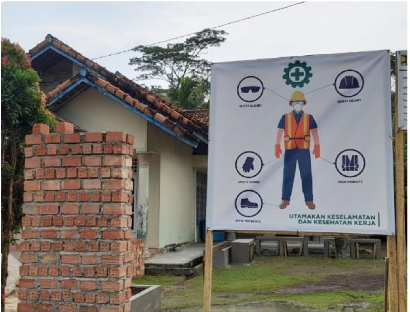
Proyek Infrastruktur Hunian Hijau di Mesuji
